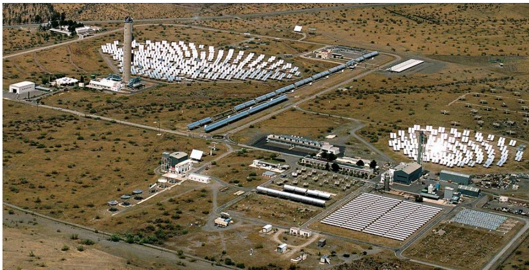
Plataforma Solar de Almería (PSA) in Tabernas, Almería (Spain)
